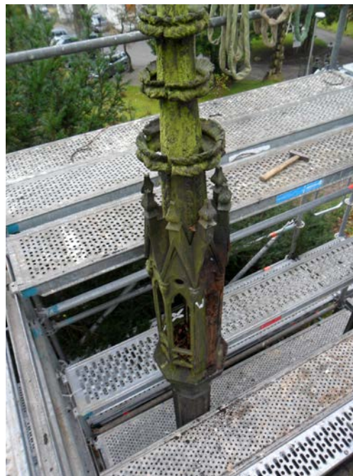
2 Freistehende Giebel nach Entfernung der Giebelbekrönung und nach Abheben der Dachplatten.
