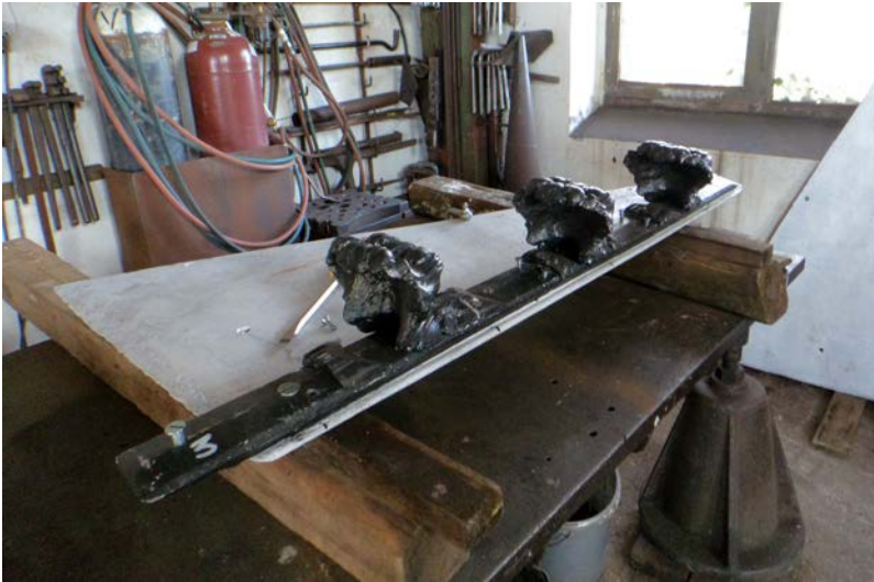
22 Noch nicht verzinkte Stahlbrücke im Inneren einer Fiale.
