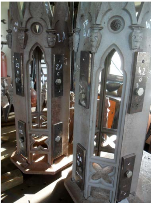
13 Fialenschaft mit Bodenplatte, fester und offener Fenstereinheit. Erkennbar die Bruchstelle am Fuß der tragenden Fenstereinheit.
