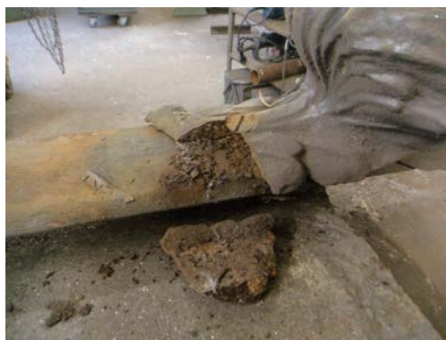
29 Schäden durch Unterrostung an einer Krabbe eines Wimpergs.
